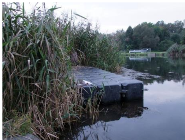
Pontonanleger am Bootshaus, stark eingewachsen
