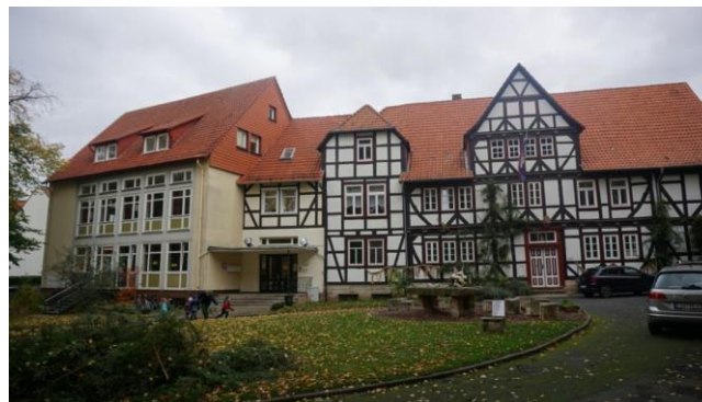
Situation vor Ort (Bildquelle: Ing.-Büro Werner)
