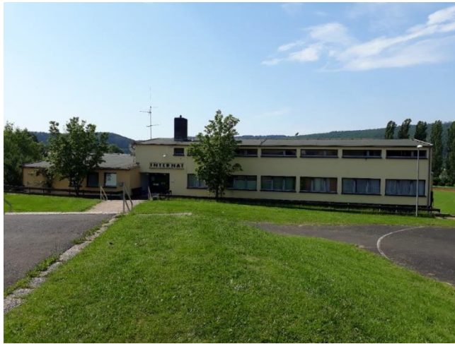
Bestandsgebäude des ehemaligen Sportinternats
