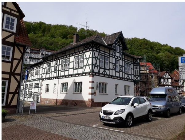
Zu großer Mix an unterschiedlichen Straßenbelägen
